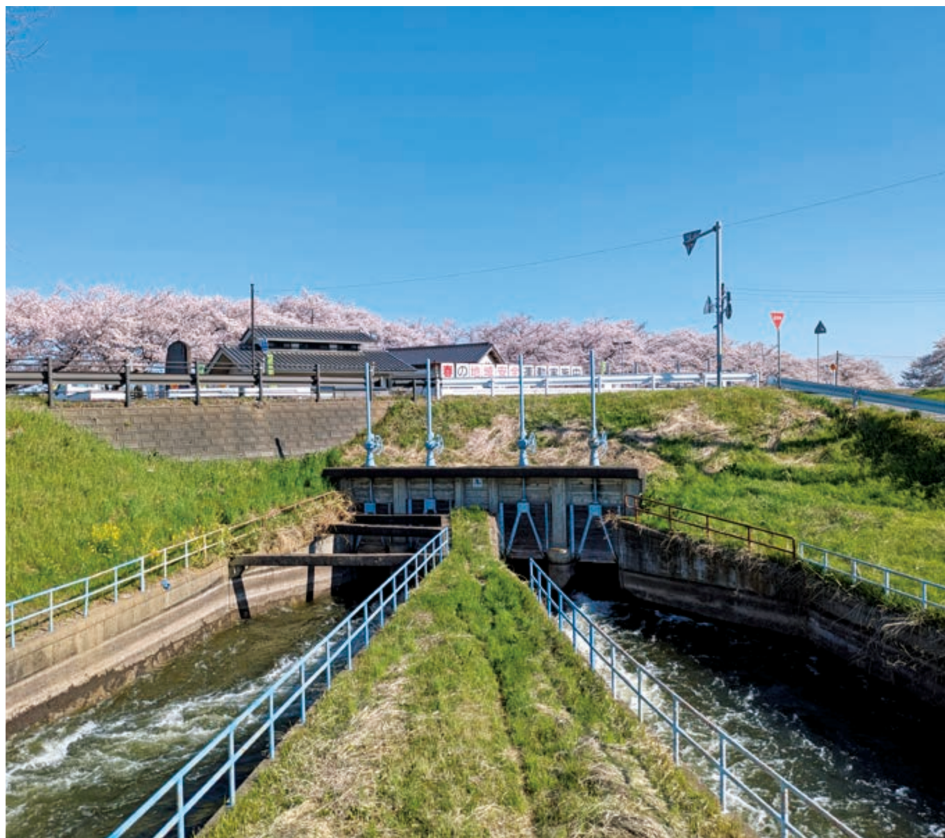
元坝樋門(台通・川通用水路)
