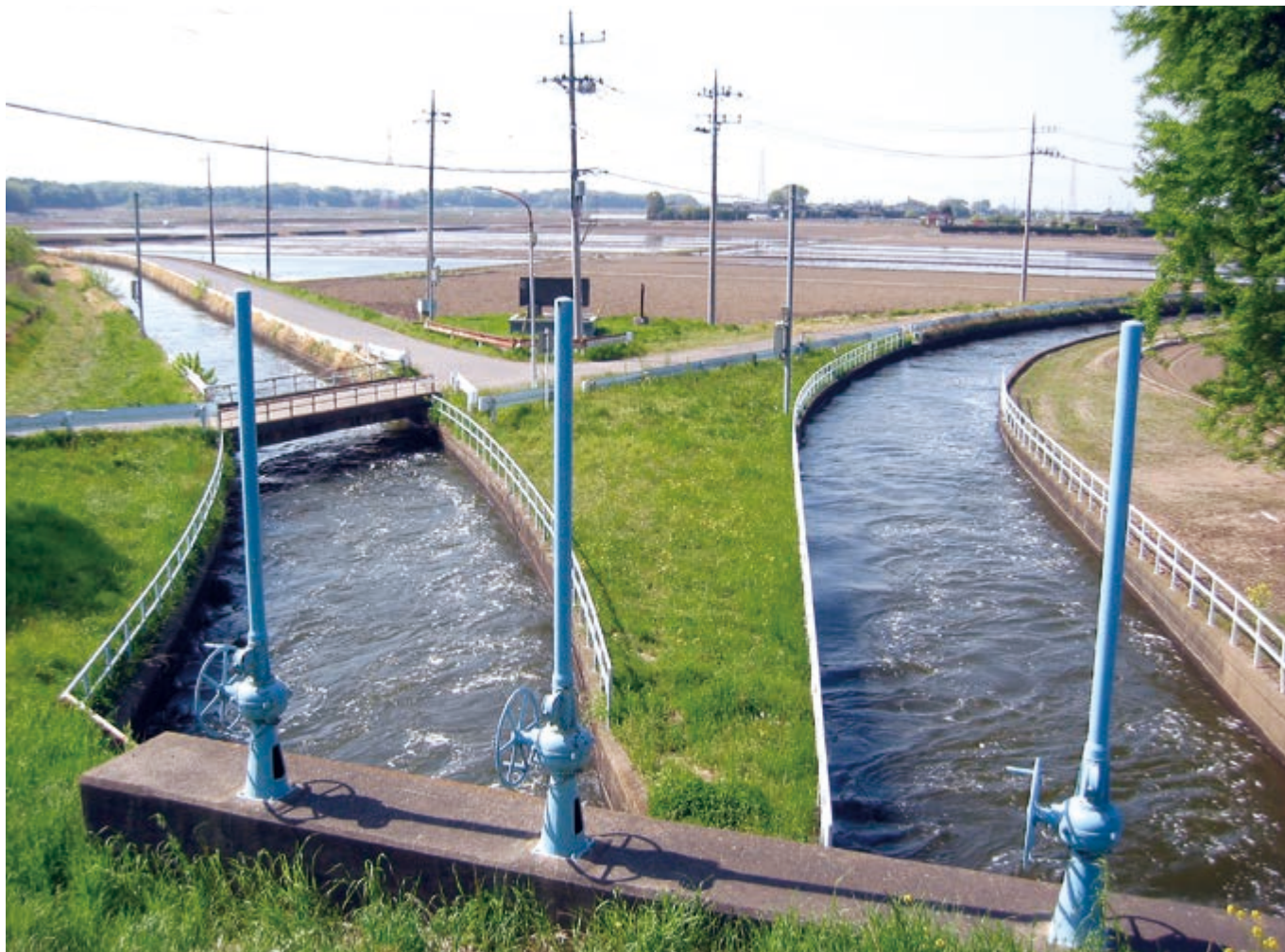
台通・川通用水路元坎樋管より
