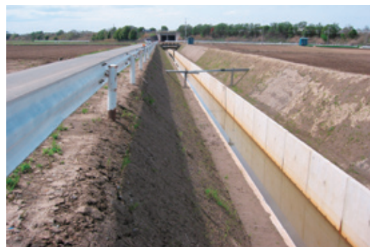
県営地盤沈下対策事業福岡堰三期地区 鐘打落排水路 施工前(左)・施工後(右)
